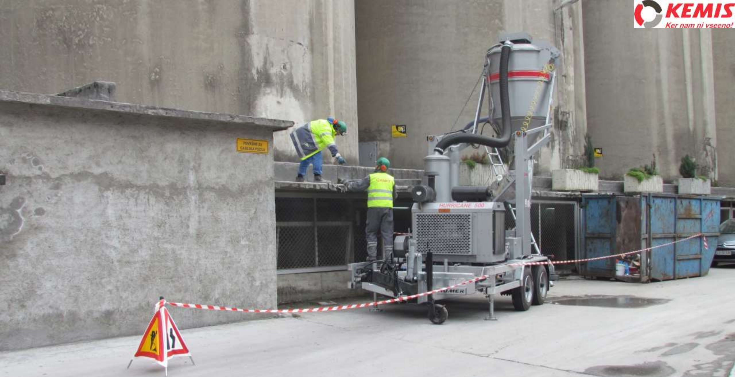
Primer praznenja silosa cementa
