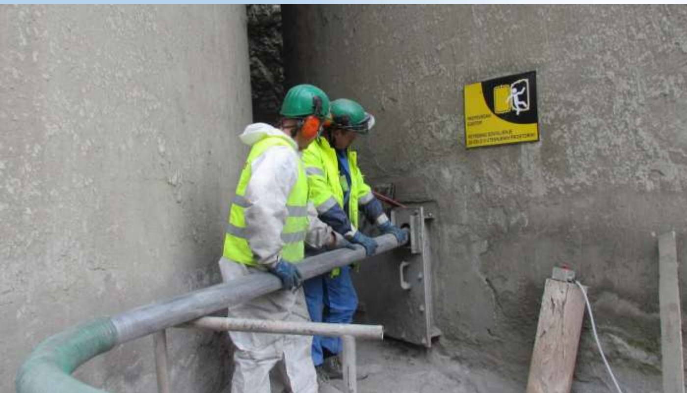
Hurricane – primer uporabe: sesanje cementa iz silosa
